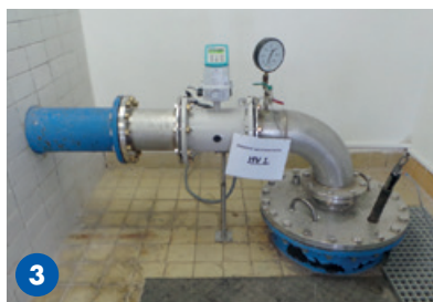
Obr. 1 Původní regulace čerpadla byla řešena uzavírací armaturou
